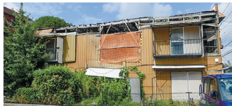
解体されるアパート
