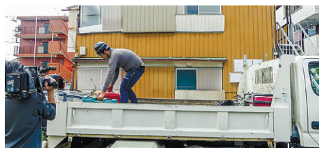
解体の準備が始まる
